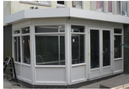
2 x draai/kiiep (Schüco handgrepen zonder slot, Winkhaus Activipilot,RCO) met hr++ glas, u=1.1, 4/16/4..
