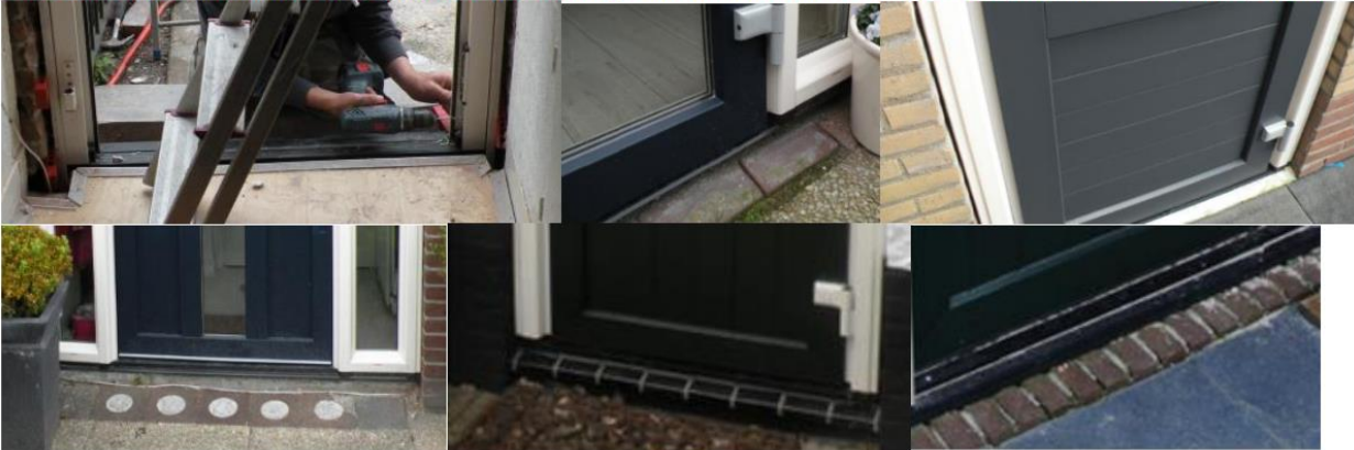
Türschwelle Accent nach innen öffnend Accent door threshold, inward-opening
