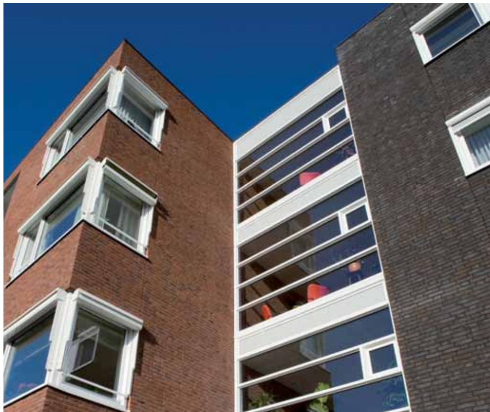
Het woonzorgcomplex te Blerick
