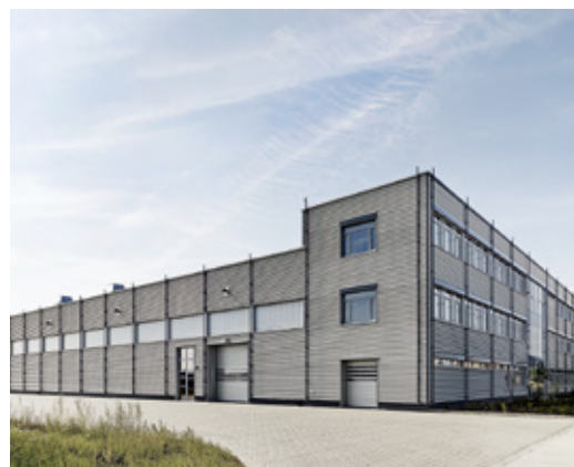
Neue Kaschierhalle am Standort der Schüco Polymer Technologies KG New foiling hall at the Schüco Polymer Technologies KG site
