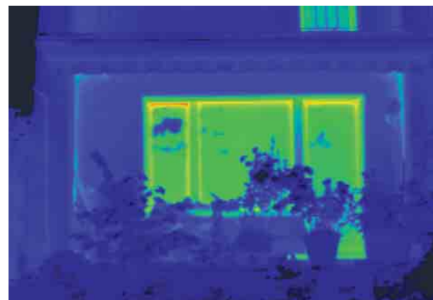
Nach dem sorgfältigen Einbau neuer Schüco Thermo 6 Cava-Energiesparfenster beweist die Thermografie den hohen energetischen Nutzen der Investition. Der ursprüngliche Energieverlust wird nahezu vollständig vermieden.
